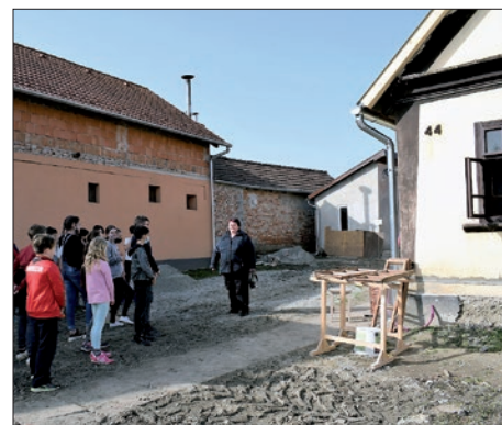
Obnova keresturske Hrvatske zavičajne kuće
