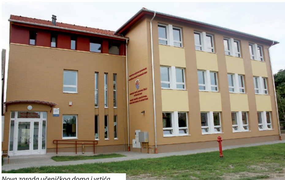
Nova zgrada učeničkog doma i vrtića
