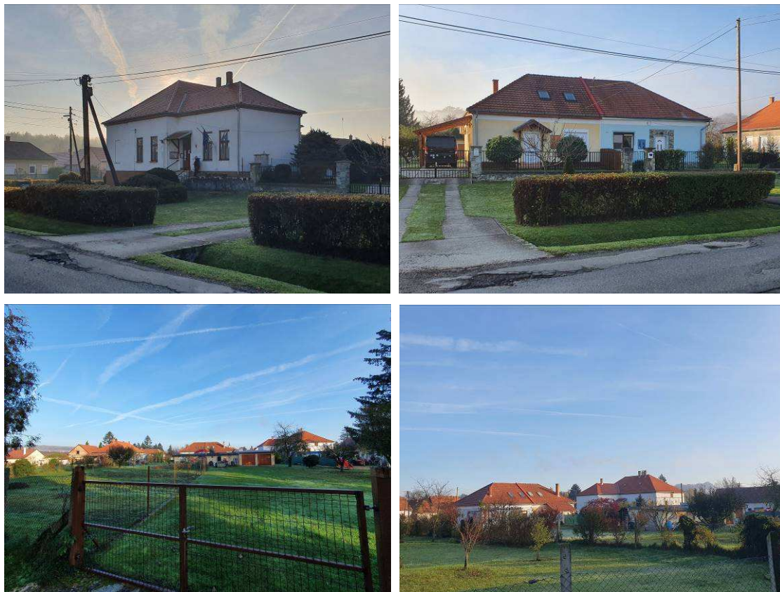
A 11/1-2 és 12 hrsz ingatlanok fényképei felső sor: Pinka utca, alsó sor: József Attila utca felől
